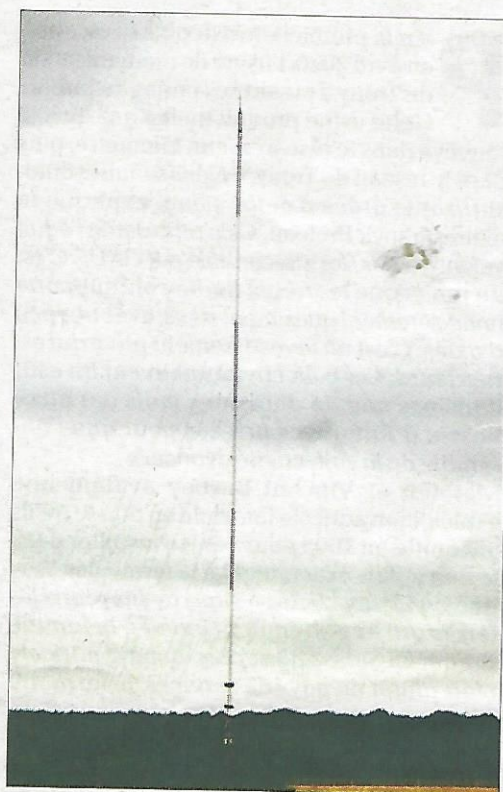
▣ Un mât d'étude est en passe d'être installé.
