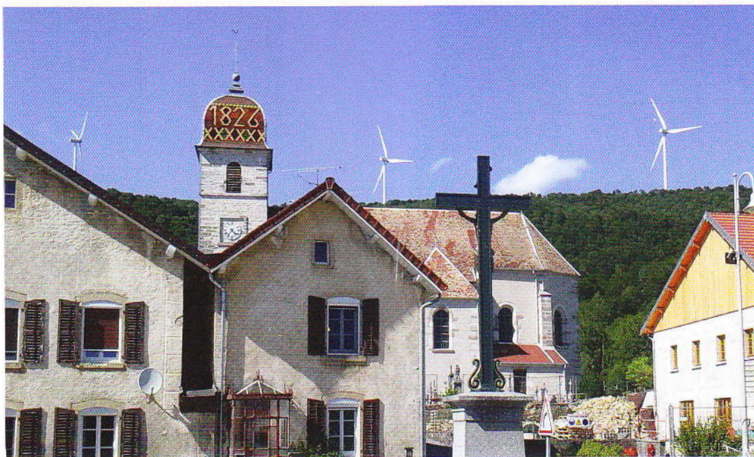
Parc éolien du Lomont, Valonne (Doubs).
