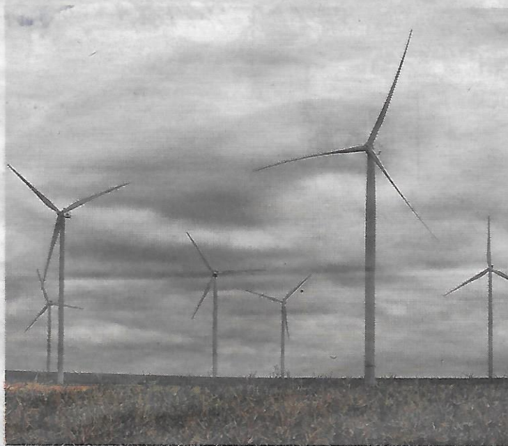
Les opposants refusent la construction de nouvelles éoliennes, comme ici, à Massay (Cher).
